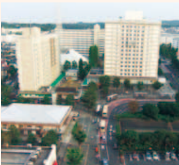
駅前の洋光台中央団地
