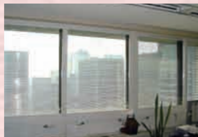
環境省(中央合同庁舎5号館)では、断熱性・遮音性に優れた高性能プラスチック断熱窓「メルツェンサッシ」を内窓に取り付けた。 写真提供：リフオジュール株式会社
