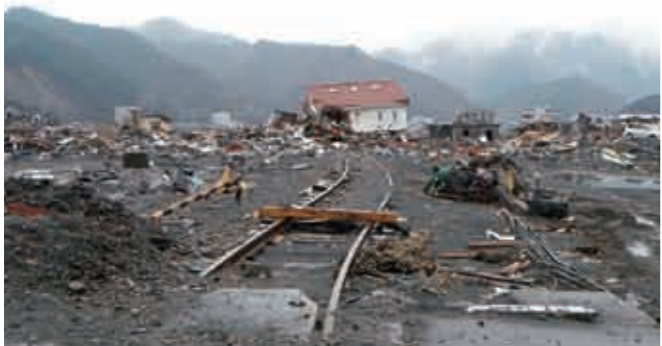
大津波により土砂に埋もれたJR山田線の線路(岩手県大槌町)
