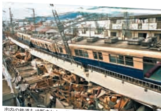
市内の鉄道も寸断された。傾いた高架線路と車輦。(阪神電鉄本線)
