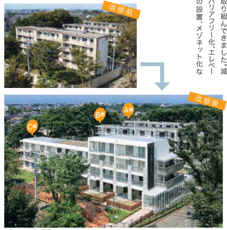
A棟 エレベーター設置によるバリアフリー化 B棟 エレベーター非設置での魅力アップ C棟 減築やアクセス改修により外観イメージを刷新 ※A棟・B棟は竹中工務店との共同研究
