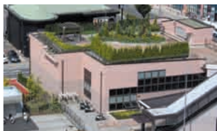
屋上庭園のある自転車駐輪場
