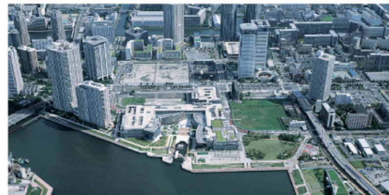
晴海大橋上空から見た豊洲の街。中央がドックを生かした水上バス乗り場
