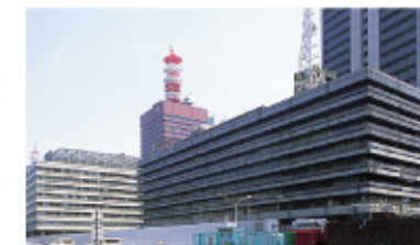
第1次再開発事業施行地となった旧合同庁舎（撤去前）
