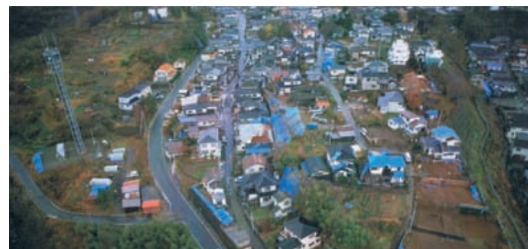
新潟県中越沖地震(震度6強)における柏崎市の被害は、死傷者1,600人以上、住宅被害28,000棟以上。概算被害額は2,200億円に及んだ。写真は番神二丁目地区
