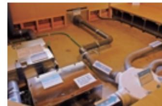
左/床下空間を利用して換気設備も設置
