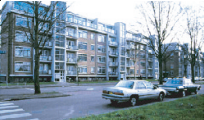
オランダ デンハーグの屋上増築 階段室型住宅の内部にエレベータを設置し、屋上に鉄骨造で一階分増築
