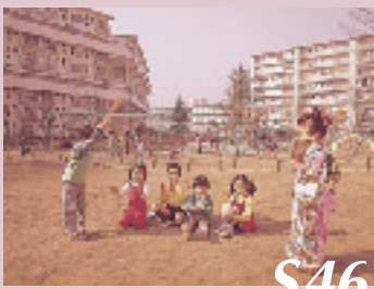
$46 奈美北(横浜市青葉區) 小田急線玉川学園前駅から徒歩15分、人気の高い沿線で適正家賃とするため、高層住棟の導入や建物配置に工夫を凝らし、3層スキップの階段室型8階建て住棟を、亀甲形について囲み配置とするなど、先進的な設計を行いました。
