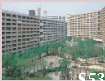
$53 川口芝園(埼玉県川口市) JR京浜東北線蔵(蔵)駅から徒歩約7分、隣接する鉄道から騒音を遮るバッファーエリアとして、総延長約500mの長大な高層住棟と公園を設けました。また鉄道を利用して砂、コンクリート、鋼管杭などの建設資材を搬入しました。
