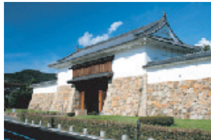
雅称 舞鶴 ぶかく 城が地名の起源となる田辺城 復元された城門
