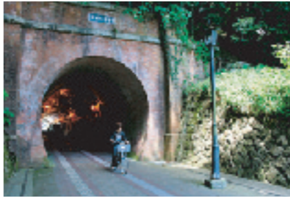
旧軍港引込線 赤煉瓦造の北吸トンネル 国登録有形文化財 1904年(明37)竣工
