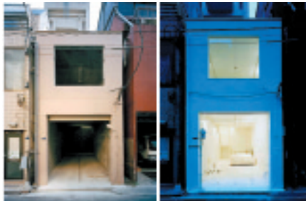
改修によって甦った ビルのファサード
