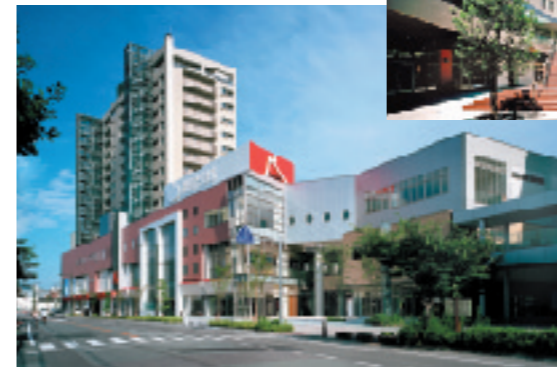
施設の外觀（北西より）
