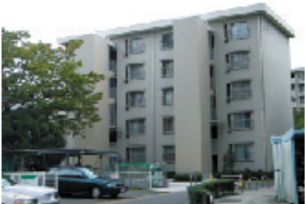
既存賃貸住宅への中層エレベーター設置事例
