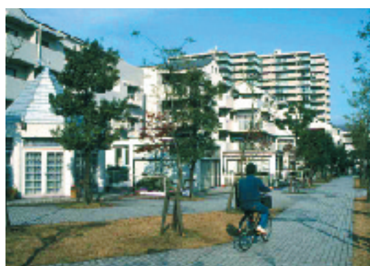
街路に面した1階に地域との交流をめざした居室を配置 (多摩ニュータウン)
