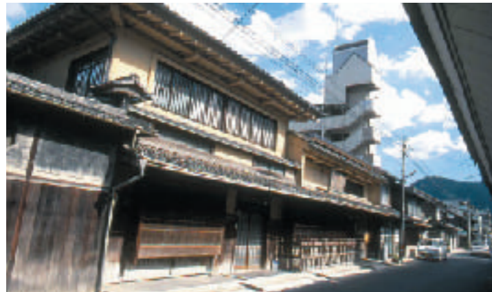
屈指の豪商 池上家邸宅 高瀬舟船主 両替商 醤油製造などを営み 現在は市商家資料館 後方の学生向けマンションが町並みの課題
