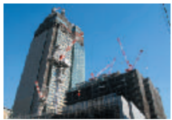
進捗する工事
