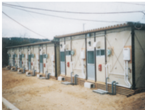
急遽建設された仮設住宅
