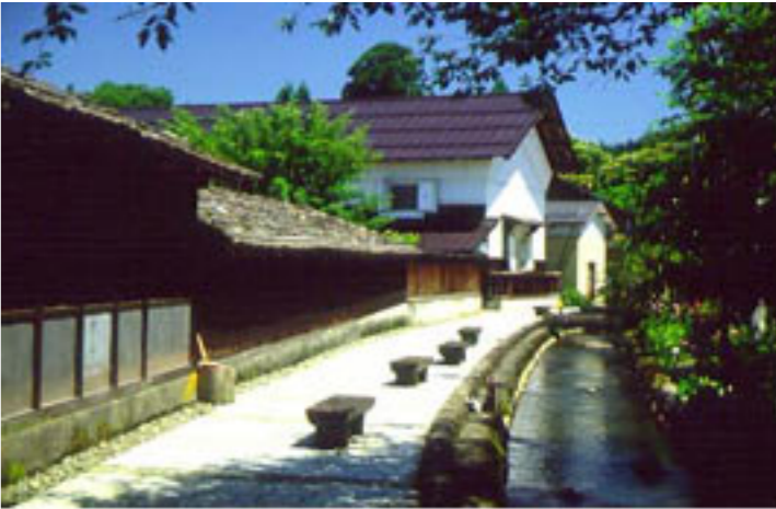
金山杉のまち 堀割を修復して景観創出 山形県金山町
