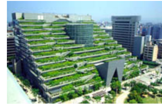
福岡県国際会館 アクロスの屋上緑化 現在は更に樹が育っている 福岡市
