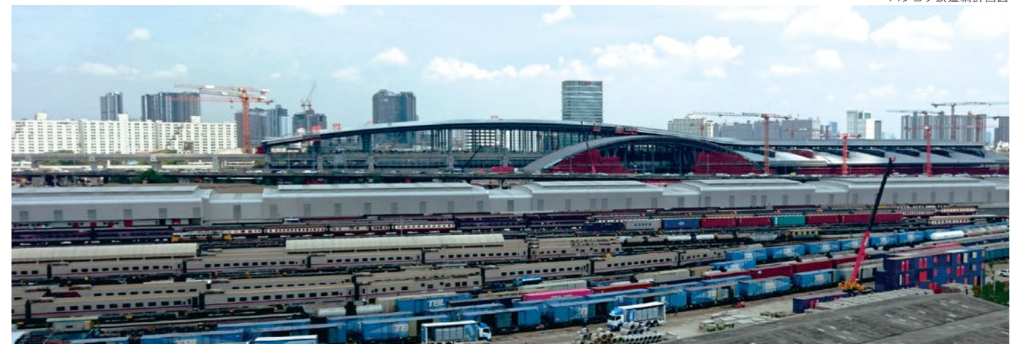
建設中のバンサー中央駅
