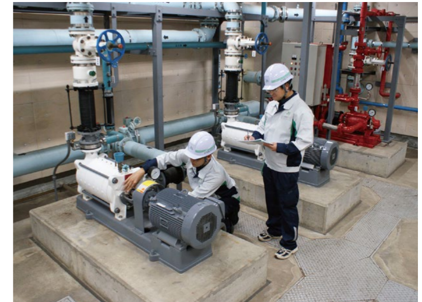
給水施設の点検
