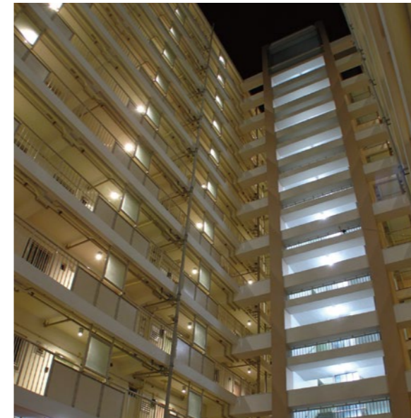
共用照明のLED化
