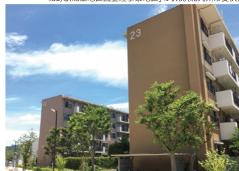
自然が映える配色を取り入れた外壁修繕
