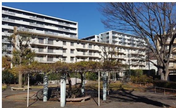
写真①：板状階段室型住棟（41号棟・2018年12月撮影）
