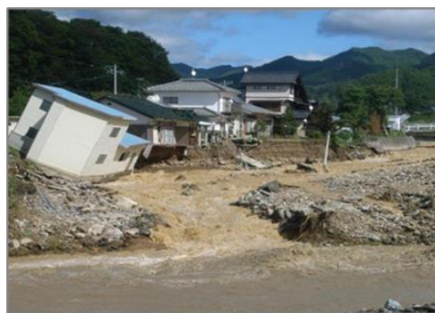
● 余地川と抜井川合流地点の被災状況（佐久穂町）
