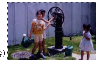
手押しポンプ(雨水利用)
