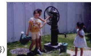
手押しポンプ(雨水利用)
