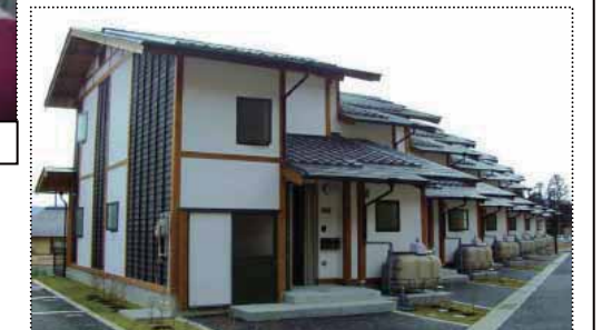
地元事業者・地元産材を活用した住宅イメージ (事例写真:岩手県営住宅)
