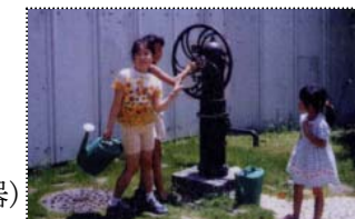
手押しポンプ(雨水利用)
