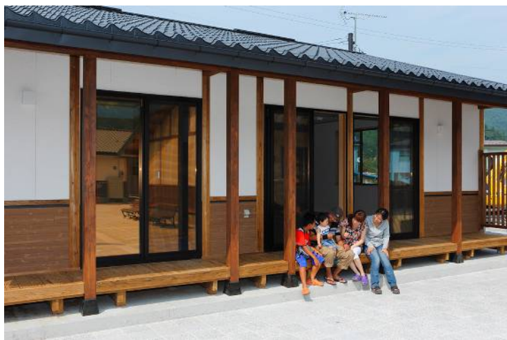
岩手県大槌町 大ケ口地区災害公営住宅（H25.8完成）
