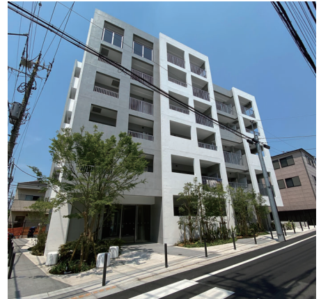
URが整備した「コンフォール品川西大井」(令和4年4月完成)
