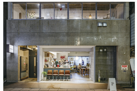
問屋ビルの改修による物件活用
