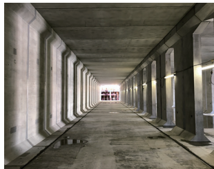
水害対応として雨水貯留槽を整備
