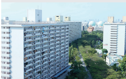
マンモス団地の建設 (高島平団地)
