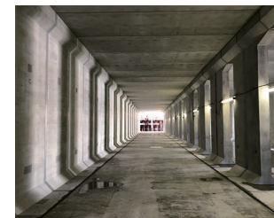
水害対応として雨水貯留槽を整備
