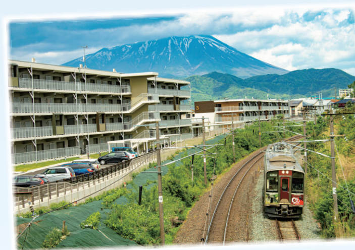
災害公営住宅県営南青山アパート(岩手県盛岡市)
