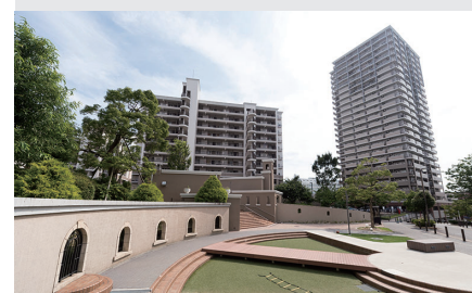
建替後の団地 (アーバンラフ星ヶ丘)
