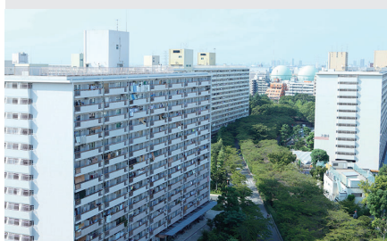
マンモス団地の建設 (高島平団地)
