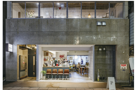
問屋ビルの改修による物件活用
