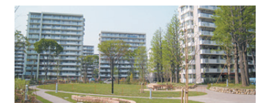
建替後の住棟
