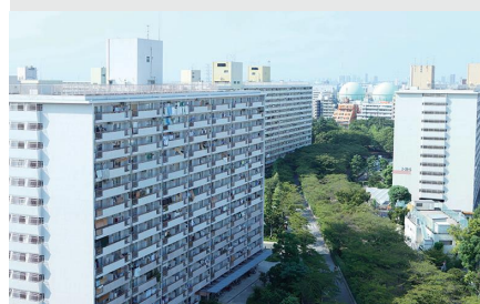
マンモス団地の建設 (高島平団地)
