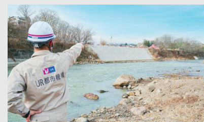
被害を受けた河川の復旧状況の確認
