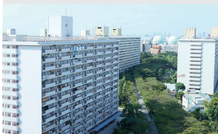
マンモス団地の建設 (高島平団地)
