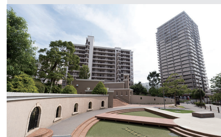
建替後の団地 (アーバンラフ星ヶ丘)
