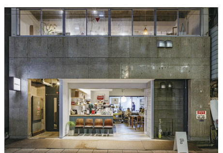
問屋ビルの改修による物件活用
