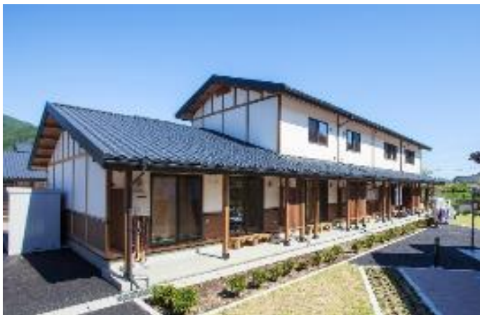
大ケロ一丁目町営住宅 (岩手県大槌町)
