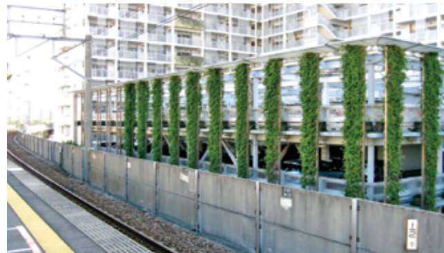
カロライナジャスミンによる登はん型壁面緑化 (潮見駅前プラザ一番街 (東京都江東区 2002))
