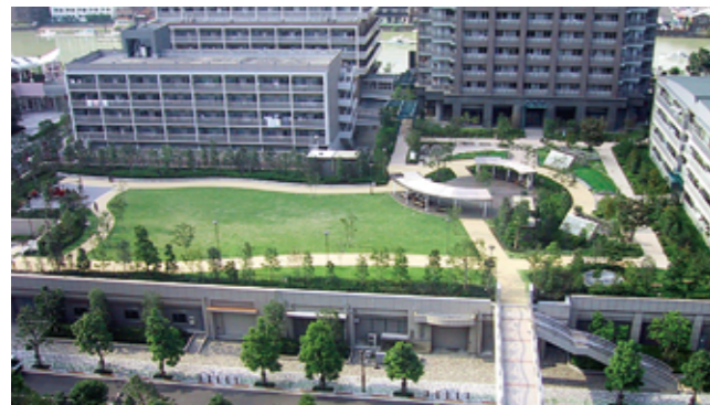
大規模な人工地盤緑化 (晴海トリトンスクエア (東京都中央区 2001))
