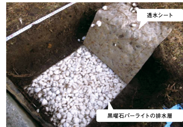
薄層土壌による屋上緑化 施工事例
