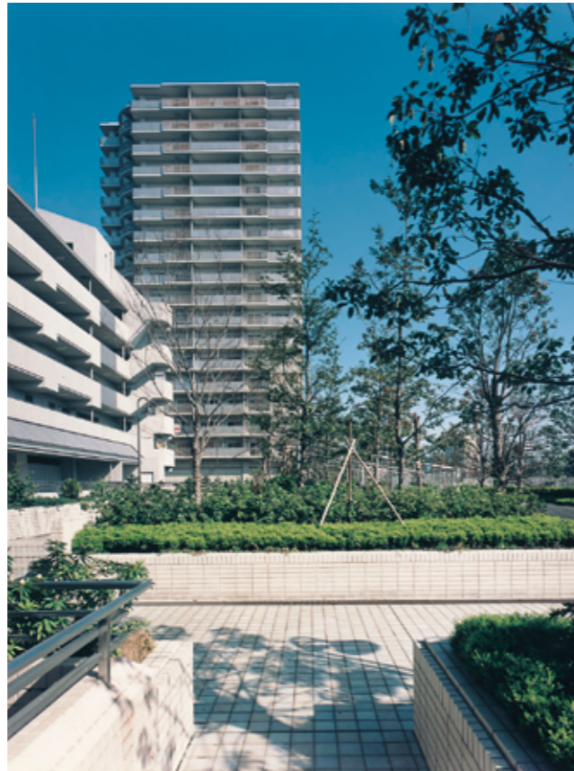
土地の高度利用により生み出された人工地盤緑化 (リバーシティ 21 (東京都中央区 1988))
