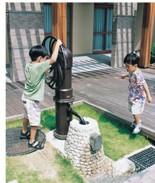
震災の教訓から生活雑用水確保のため設置した雨水貯留槽から雨水をくみあげる手回しポンプ (HAT 神戸・灘の浜 (兵庫県神戸市 1998))
