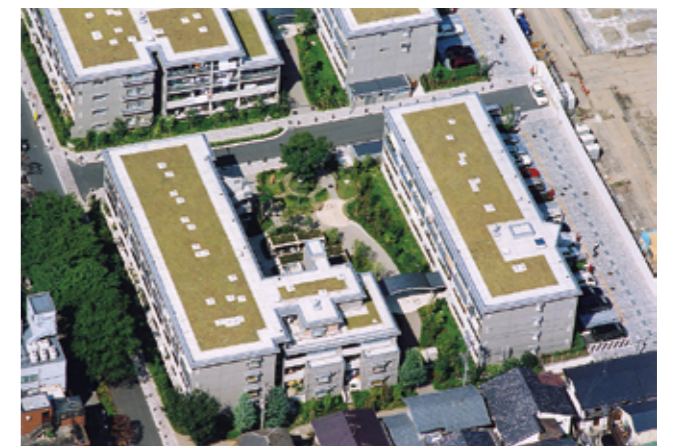
薄層土壌による屋上緑化標準仕様で整備 (シティコート二子玉川 (東京都世田谷区 2002))
