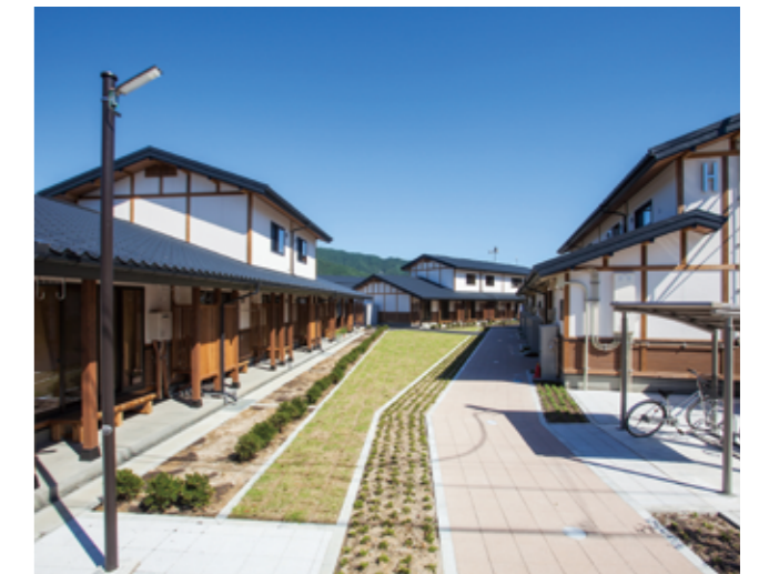
西方向より住宅を望む
