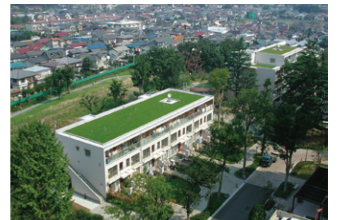
住棟の屋上緑化を本格実施 (グリーンプラザひばりが丘南 (東京都西東京市 2001))
