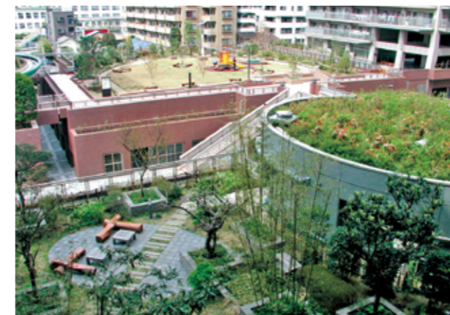
雨水を利用した屋上ビオトープ (アーベインビオ川崎 (神奈川県川崎市 2001))
