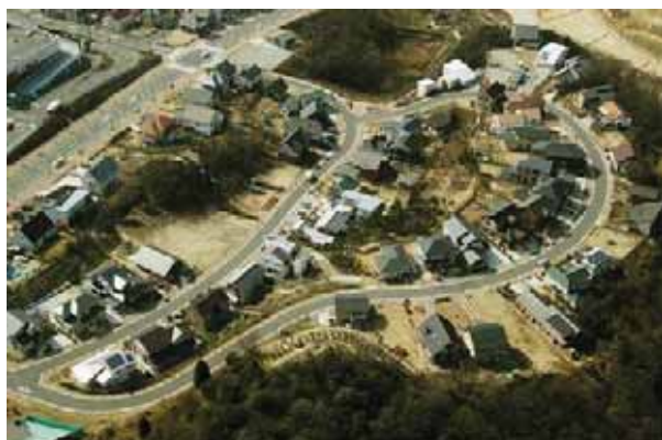
地区を上空から望む。道路は地形に沿ってなだらかな曲線で構成。現況林を含む平均約700㎡の大規模な64区画の宅地が並ぶ。
