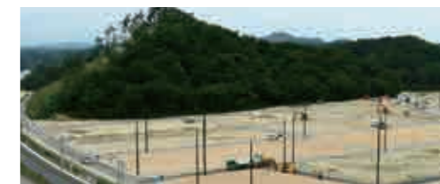
西工区の造成状況(2016年6月)
