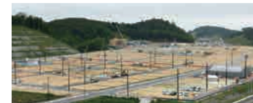
中工区の造成状況(2016年6月)
