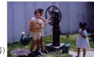
手押しポンプ(雨水利用)
