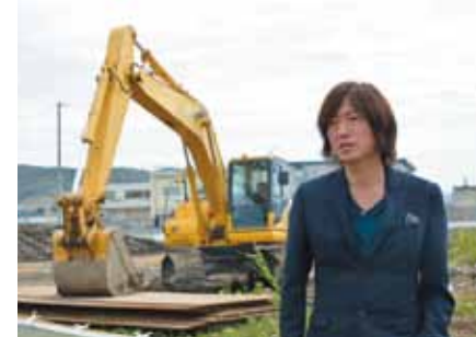
上/緑深い高台の日和山公園から新門脇地区、復興祈念公園予定地を望む。その向こうには石巻湾の景色が広がる 下/住宅建設開始に向けて準備の進む現場にて
