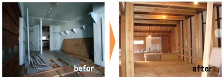
写真5 風東長屋 耐震リブフレーム
