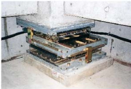
免震材料（偏心滚轴支撑）
