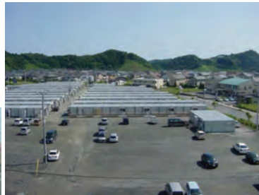
いわきニュータウン 仮設住宅用地
