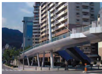
▲風をテーマに潮風をイメージした「灘スカイデッキ」
