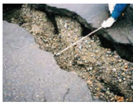
▲被害状況調査の様子
