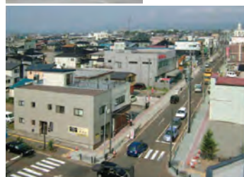
▲復旧後のえんま通り
