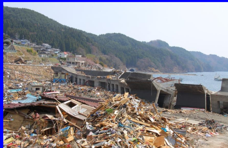
小白浜防潮堤
