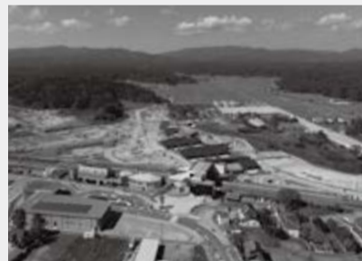
福島県双葉町 双葉駅西側地区（駅周辺）
