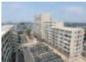
建替え後のコンフォール東鳩ヶ谷団地
