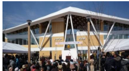
【女川駅舎と温浴施設】
