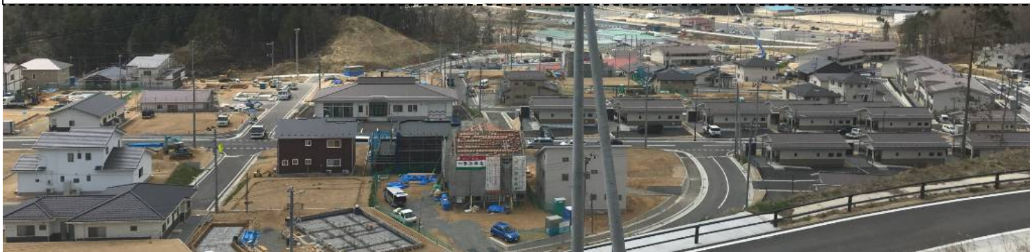
平27.10より入居者により建築が開始され、再建が進む三王団地(平28.4撮影)
